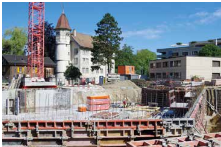
28. Mai: Die Wände des UG werden betoniert
