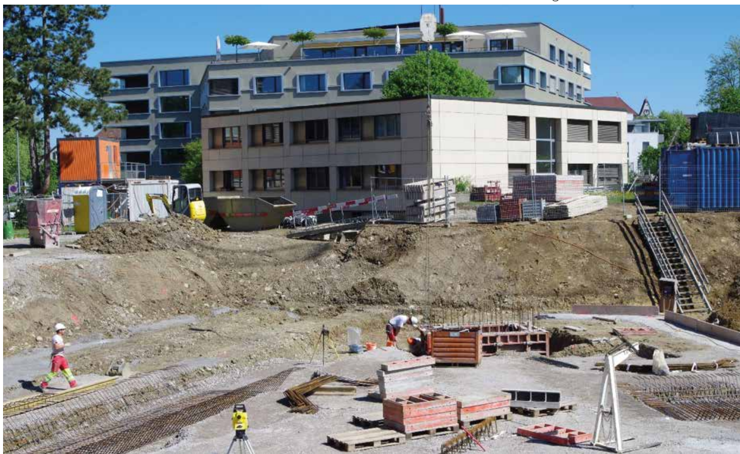
7. Mai: Der Sockel des Untergeschosses ist bereits betoniert
